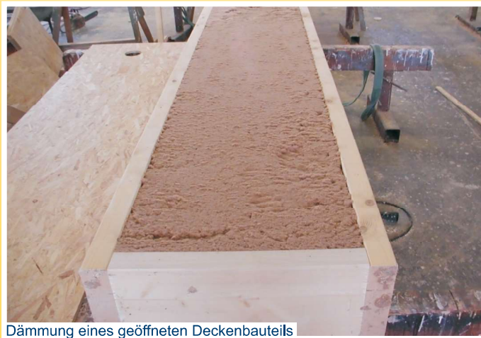
Dämmung eines geöffneten Deckenbauteils
